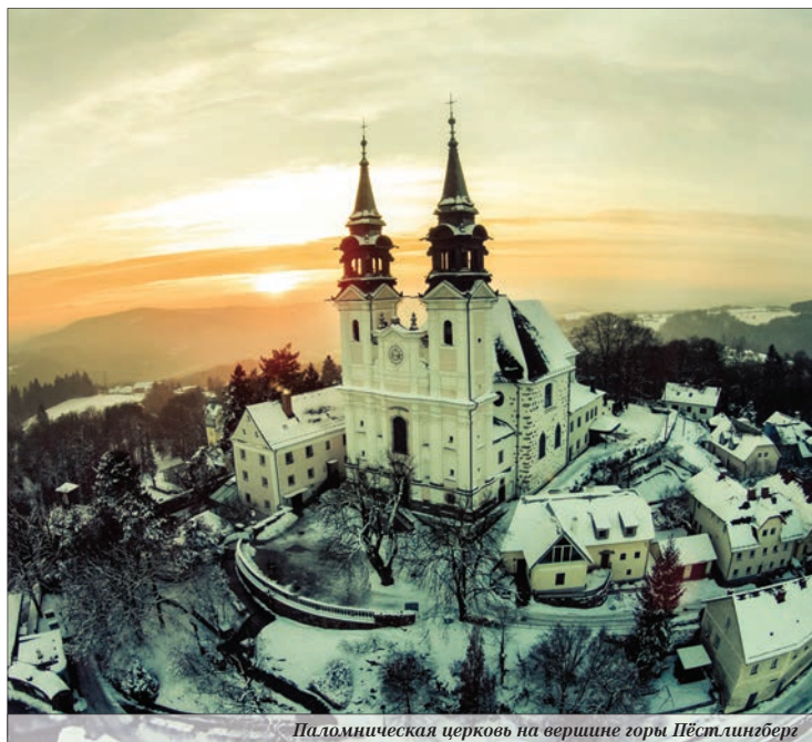
Паломническая церковь на вершине горы Пёстлингберг
