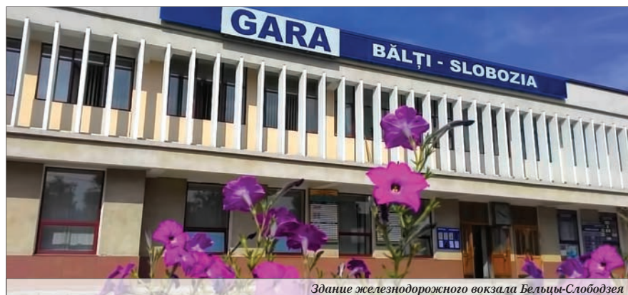
Здание железнодорожного вокзала Бельцы-Слободзея
