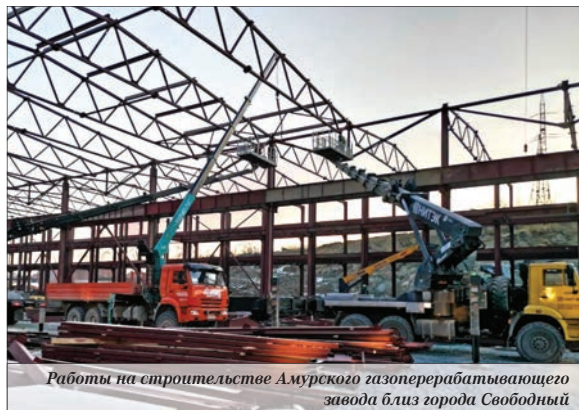
Работы на строительстве Амурского газоперерабатывающего завода близ города Свободный
