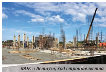
ФОК в Ветлуге, ход строительства
