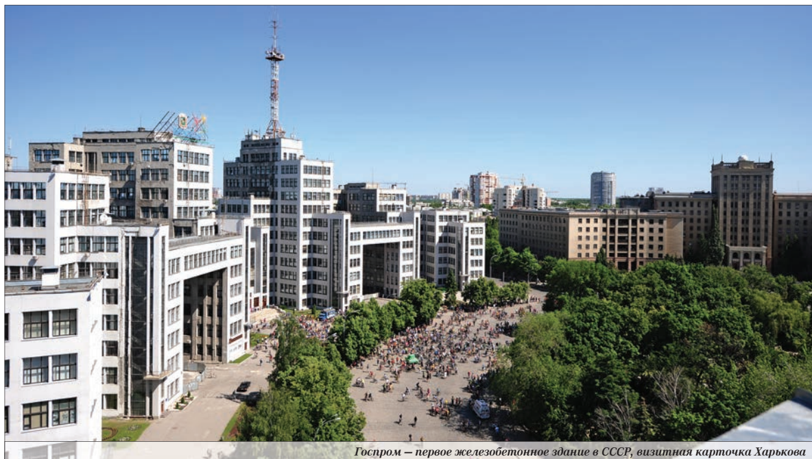
Госпром — первое железобетонное здание в СССР, визитная карточка Харькова
